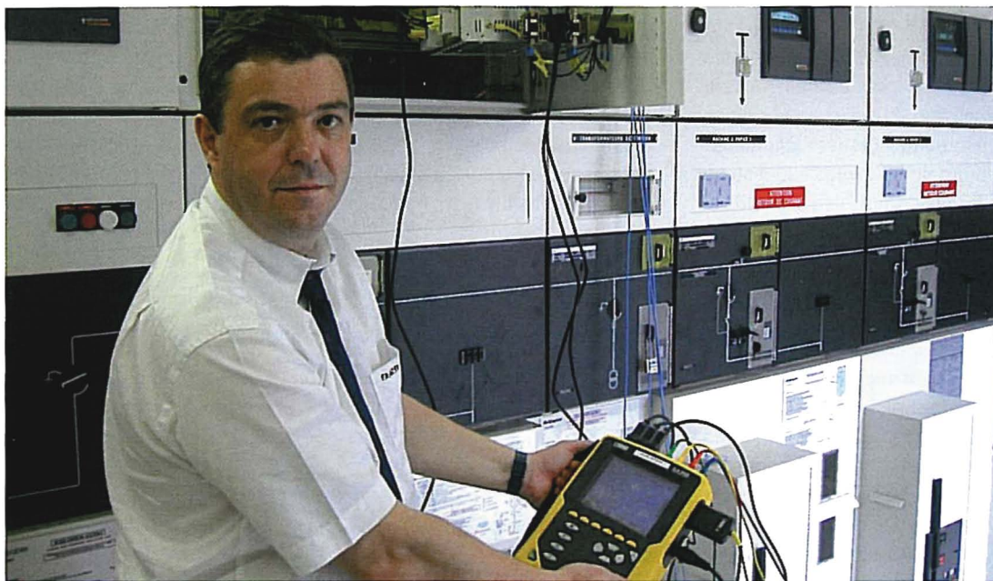
Mise en place des appareillages à l'occasion d'une expertise sur site (Doc. Chauvin Arnoux)
